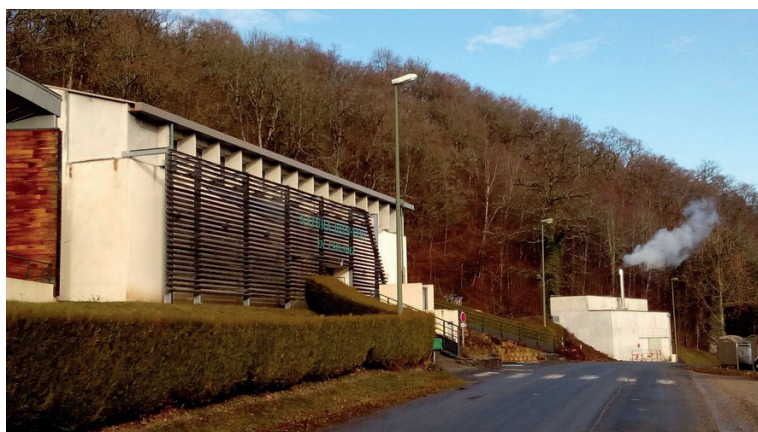
Exemple de réalisation : réseau de chaleur à Brommat
